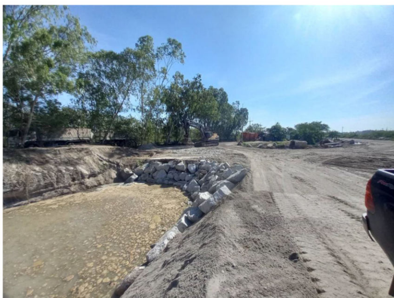
รูปที่ 6 บ่อคัดตะกอนและเก็บน้ำไว้สำหรับรดน้ำผักฟุ้ง
